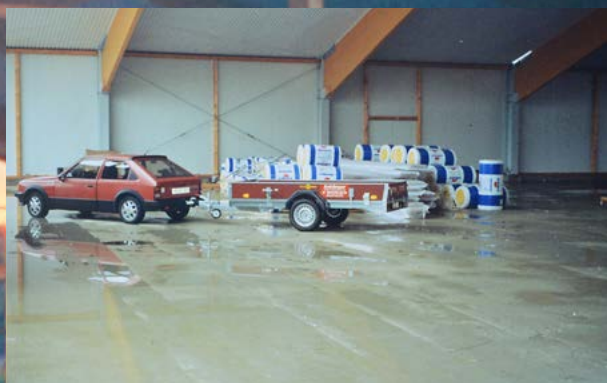
1994 entsteht die neue Tennishalle. Die Bauarbeiten übernimmt eine Fachfirma, trotzdem bleibt für die Vereinsmitglieder noch genug Arbeit übrig ...
